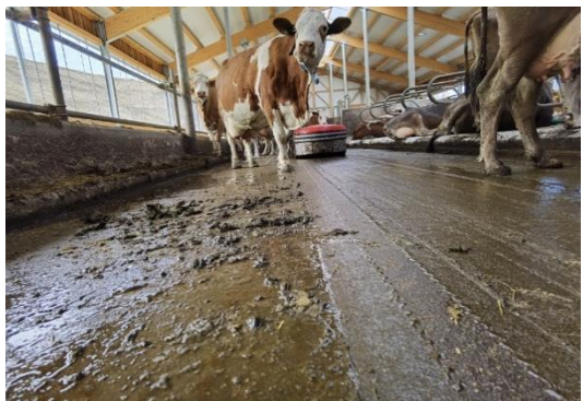
Abbildung 4: Auf unprofilierten Betonoberflächen räumt der Sammelroboter besser als ein Mistschieber. Wichtig ist allerdings, dass kein „Sumpf“ auf den Laufgängen entsteht. Dies lässt sich mit einer guten Routenwahl einfach verhindern.
